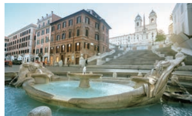
スペイン広場(ローマ・イタリア) 世界遺産 スペイン階段やバルカッチャの噴水などの修復工事が2016年に終わり、綺麗によみがえりました。【オプションツアー】
