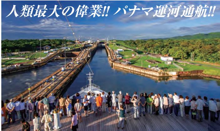
旧運河を通航可能な船舶は、全長294m、全幅32.3m、喫水12mまで、新運河では全長366m、全幅49m、喫水15.2mまでに限られます。水門式エレベーターで上下しながら進み、熱帯雨林の水道を抜け、冒険気分も味わえます。
